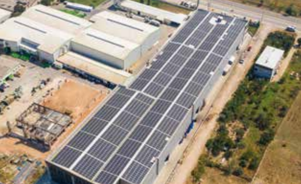
BURSA KESTEL 941 kWp - 2019
