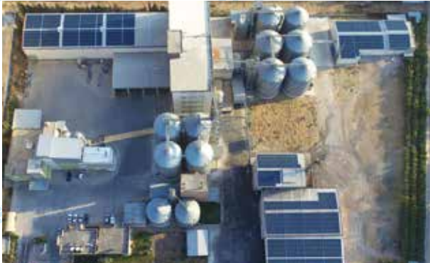
MARDİN MERKEZ 581 kWp - 2021
