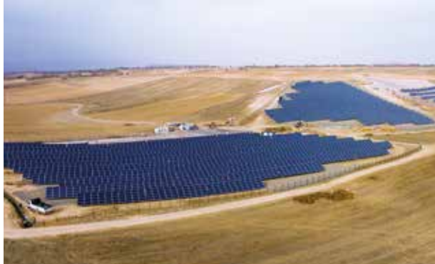
NEVŞEHİR MERKEZ 2 MWp - 2017
